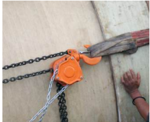
Şekil 10 Çektirme ile ctp boru montajı yapılması
